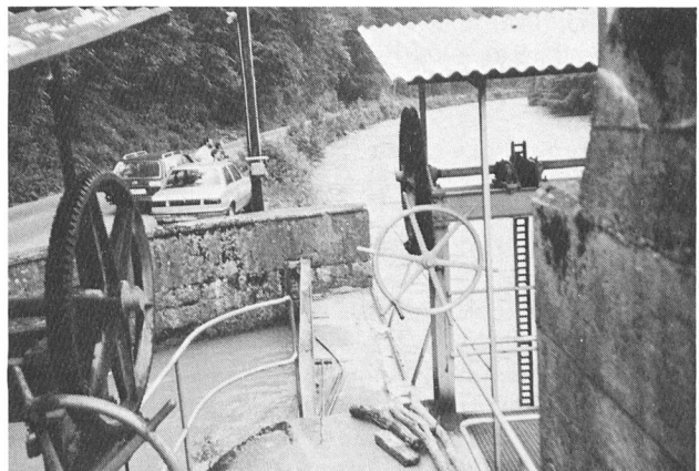
Bild 1. Die Wasserfassung vor Umbau. Baujahr 1911 bis 1912.
