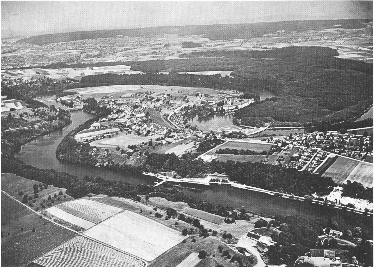
Bild 4. Blick in Richtung Nord-Osten über Rheinschleife und Halbinsel Rheinau. Deutlich erkennbar sind das Stauwehr, das ehemalige Kloster Rheinau, das obere Hilfswehr, das untere Hilfswehr und der Stollenauslauf unterhalb des unteren Hilfswehrs (vgl. Bild 2).
