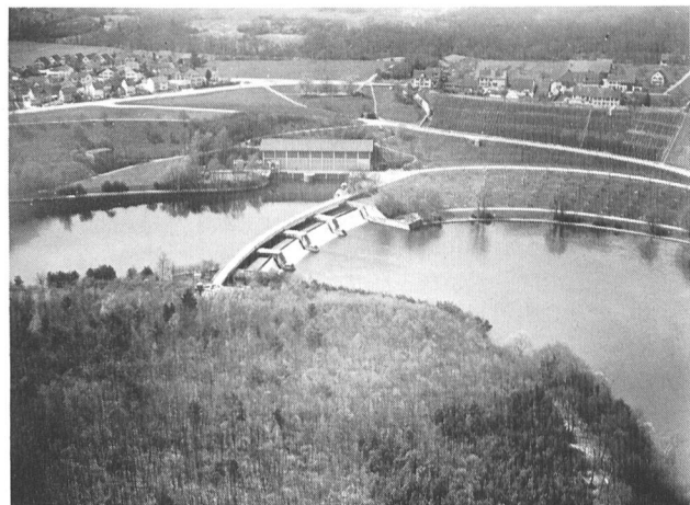
Bild 3. Stauwehr und Maschinenhaus des Kraftwerks Rheinau.
