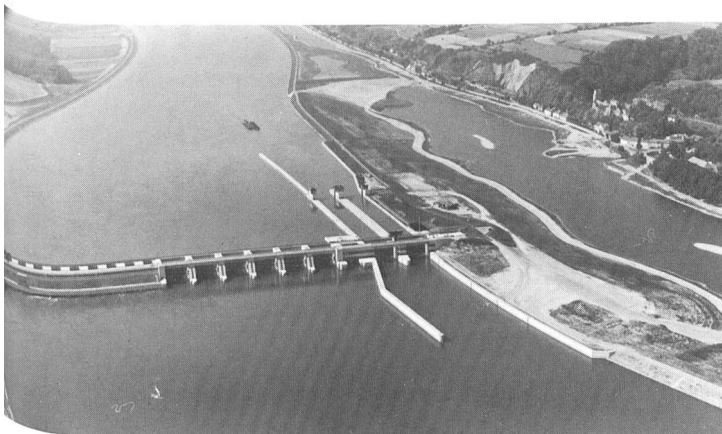
Bild 6. Laufkraftwerk (links), Wehr- und Schleusenanlage (Mitte) und rekultivierter Altarm der Donau Ende September 1983.
