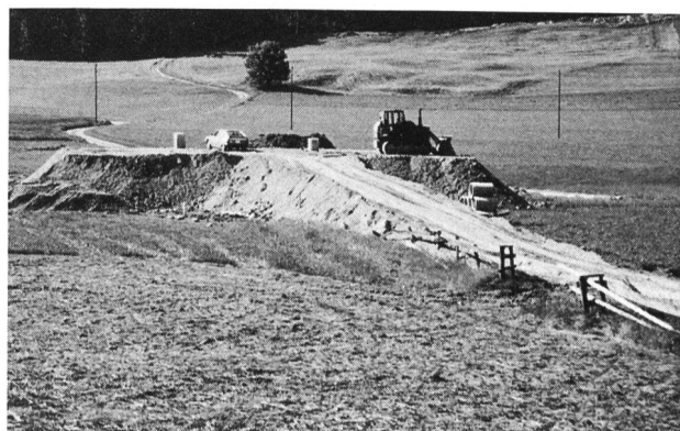
Bild 10. Vorbelastung des Dammuntergrundes, Juni 1981.
