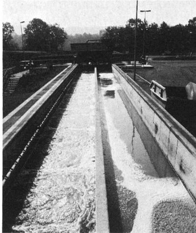
Bild 4. Sandfang-Ölabscheider.
