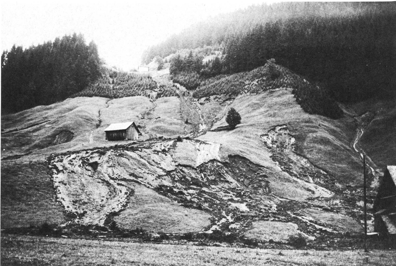
Bild 4. Typische Schäden im Landwirtschaftsgebiet talaufwärts der Ortschaft Alphthal. Hydraulische Grundbrüche lösten Rutschungen aus, welche kleine Murgänge abflossen. (Foto EAFV)
