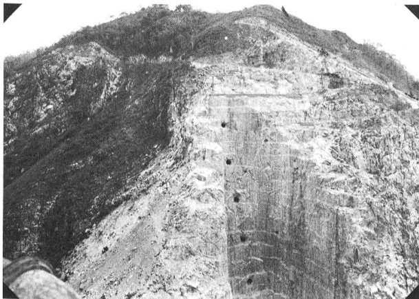
Bild 3. Talflanke mit Widerlager am Ende des Ausbruchs. Aufnahme mit der terrestrischen Messkammer P31.
