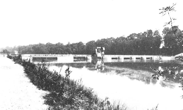
Bild 7. Reusskraftwerk Bremgarten-Zufikon, Inbetriebnahme 1975. Ma- schinenhaus (links) und Wehr (rechts) sind als solche kaum zu erkennen. Sie überragen den Stauspiegel nur wenig.
