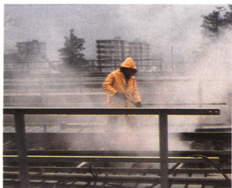
Hochdruck-Wassersandstrahlen
