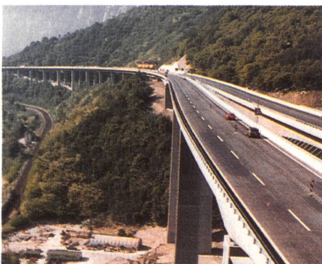
Polyesterbeschichtung auf Viaduktbrüstungen
