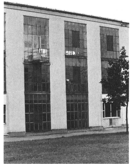
Bild 11. Grosse, moderne Verglasungen des Schalt- hauses in Ryburg-Schwörstadt.
