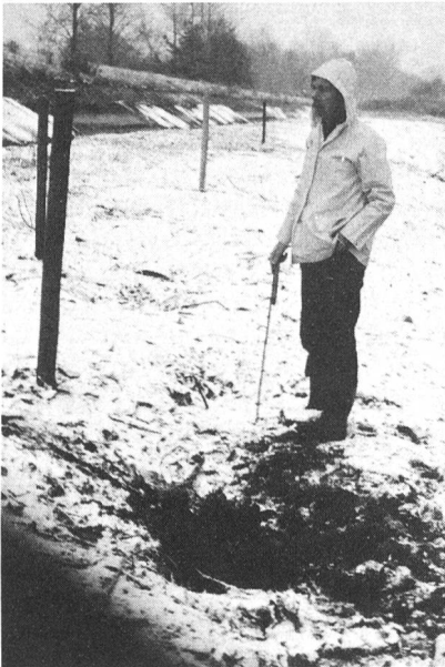
Bild 2, links. Wassereintrittstrichter in der rechtsufrigen Buchtaufanlandung.
