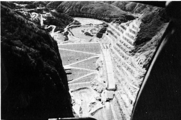
Figure 3. Pueblo Viejo : vue de la digue.
