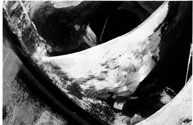
Figure 4. Roue turbine Francis, sortie d'aube réparée.
