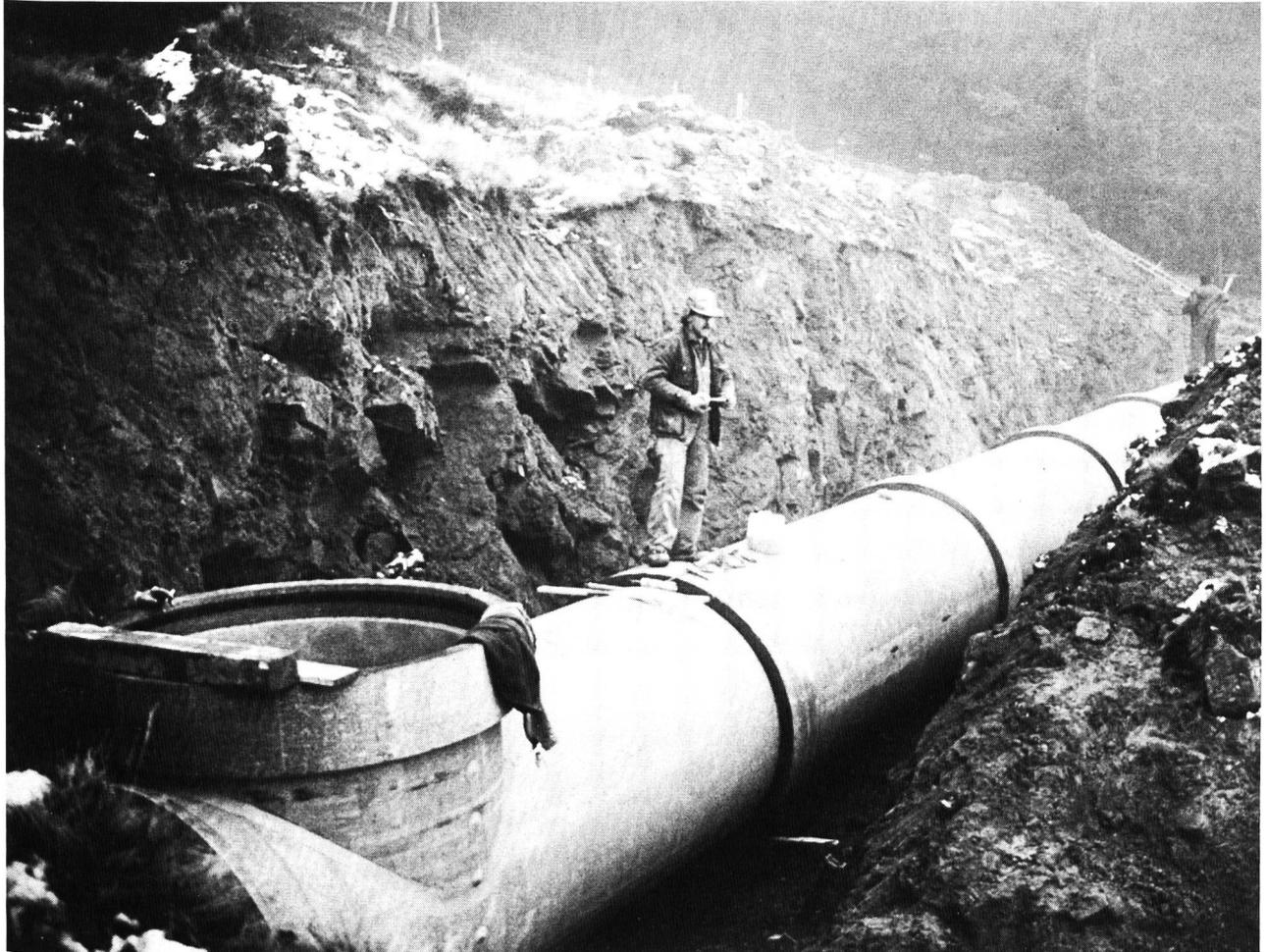
Für das Hotel Langis auf dem Glaubenberg ob Sarnen musste im Spätherbst 1984 kurzfristig ein Trinkwasserreservoir von 30m<sup>3</sup> Inhalt gebaut werden. Im Eternit-Werk wurde der Behälter mit sämtlichen Armaturen und in montagegerechten Elementen vorfabriziert. Wegen des recht unwegsamen Reservoirstandortes erfolgte das Versetzen mittels Helikopter. Die gewählte Variante erwies sich im Vergleich zu Ortsbeton als bedeutend kostengünstiger.
