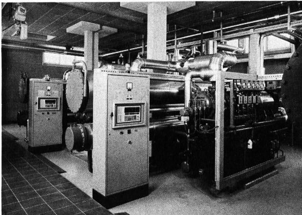
Das Wärmepumpen-Heizsystem wurde aus Gründen der Wirtschaftlichkeit, des Umweltschutzes sowie der Diversifikation der Energieträger gewählt. Auch die Studenten im vierten Jahr haben ihren Nutzen. Eine der beiden Wärmepumpen wird mit umfangreicher Instrumentierung ausgerüstet. Damit lernen sie die Auswertung mit Datenerfassungsgeräten.
