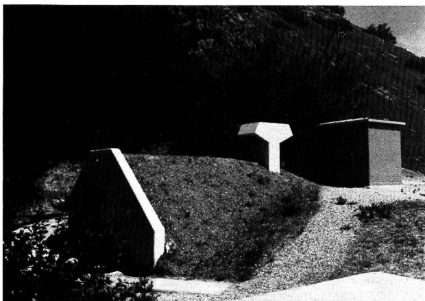
Gerade in Berggebieten kann die Trinkwasserversorgung häufig zugleich für die Stromproduktion herangezogen werden: Hier das elegant in die Landschaft eingepasste Kleinwasserkraftwerk Balavaud in der Nähe von Sitten (VS), dessen Wasser nach getaner «Arbeit» die Wasserversorgung der Gemeinden Conthey, Vétroz und Ardon speist. (Bild: Elektrowatt)
