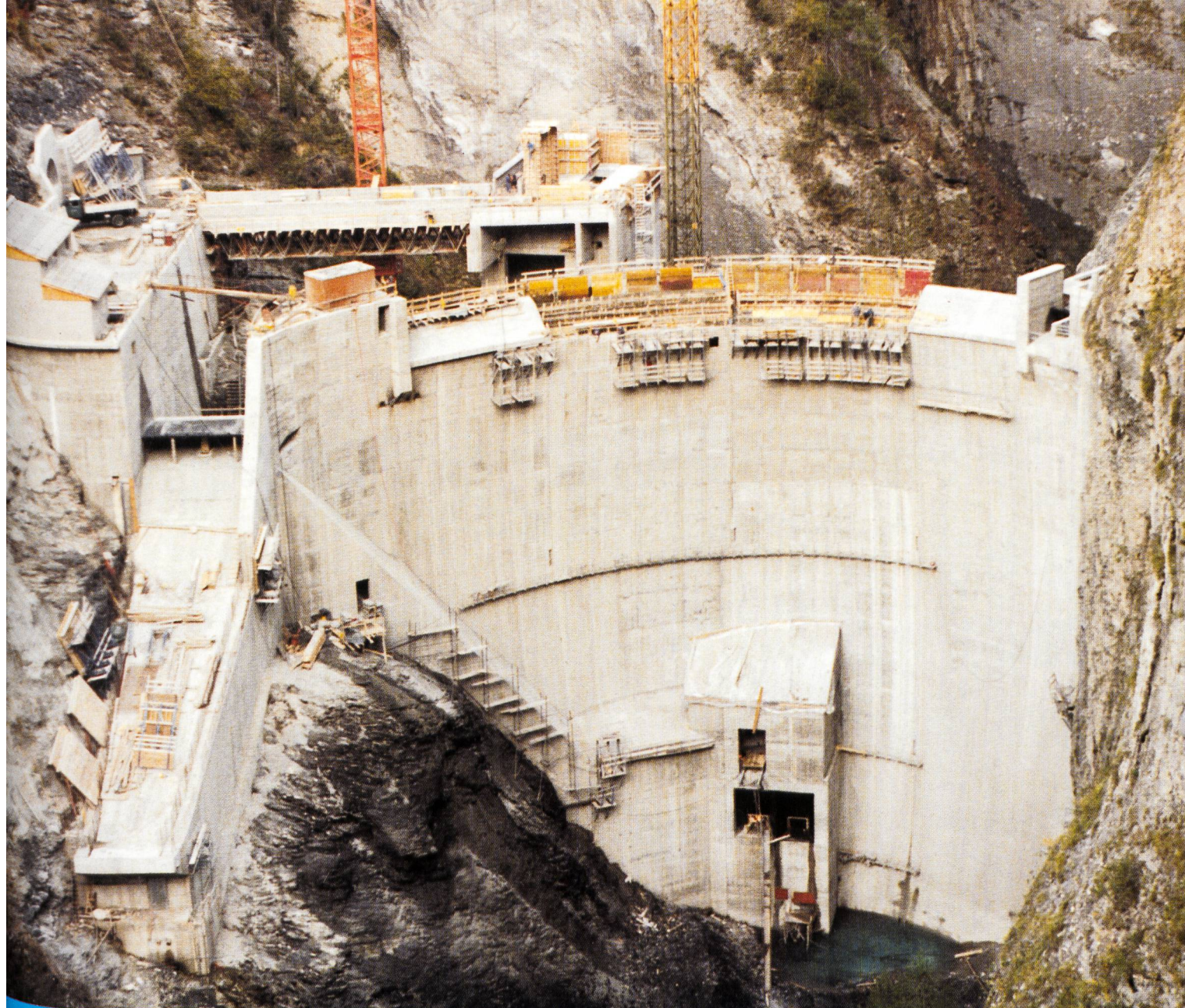
Die Staumauer Solis der Kraftwerkgruppe Mittelbünden hilft die Stromversorgung der Elektrizitätswerke der Stadt Zürich (Bauherr) sichern. Die doppeltgekrümmte, 75 m hohe Bogenmauer ersetzt das überalterte Wehr Nisellas; sie konnte am 7. Oktober 1986 eingeweiht werden.
