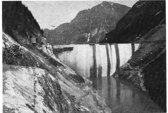
Barrage de Gigerwald, Suisse
