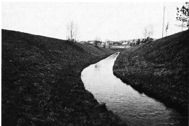
Bild 1. Oberlauf des Nefbachs (Chrebsbaches), ausgeführt gemäss Projekt 1966.
