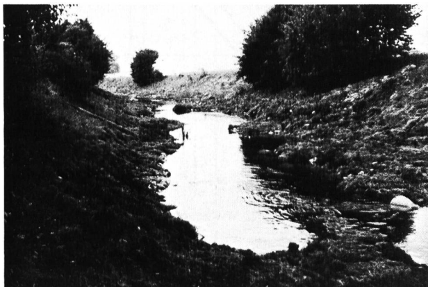
Bild 3. Umgestalteter Abschnitt des Nefbachs kurz nach Beendigung der Aushubarbeiten.
