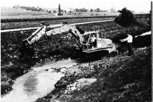
Bild 2. Revitalisierungsarbeiten am Nefbach, September 1986.
