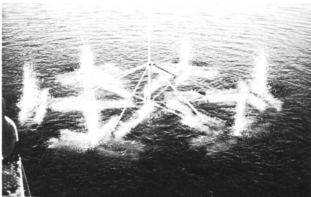
Bild 5. Ein Diffusor mit 6 m Durchmesser hat 42 Filterkerzen aus gesintertem Stahl, welche Blasen von weniger als 1 mm Durchmesser erzeugen. Zusätzlich sind 3 bis 6 Düsen für den grobblasigen Betrieb installiert, die bei einem landseitigen Druck von mehr als 7 bar ansprechen. Im Sommer können so 5 bis 40 kg O 2 /h ausschliesslich feinblasig, im Winter 50 bis 100 m 3 Druckluft/h überwiegend grobblasig (wie Foto) eingetragen werden.
