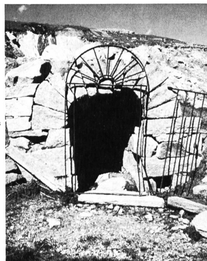
Figure 7. L'ouvrage de captage par galerie (1895); hors service.
