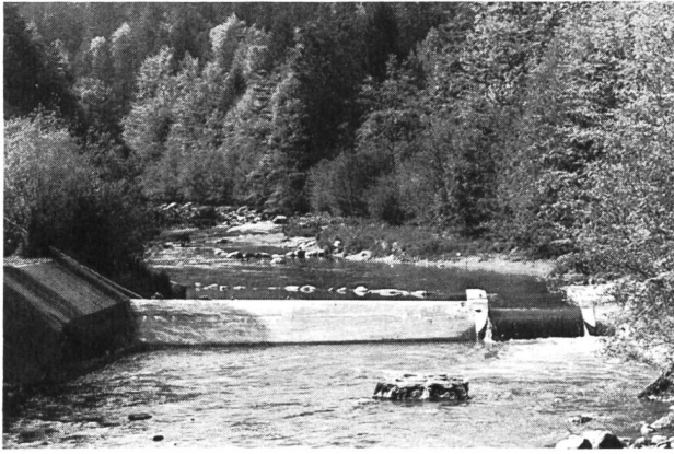
Bild 3. Dieses bereits bestehende Messwehr in der Sihl wird um ungefähr zwei Meter erhöht und durch eine neue Wasserfassung ergänzt.
