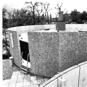
Faulanlage, Vilette, Gent
