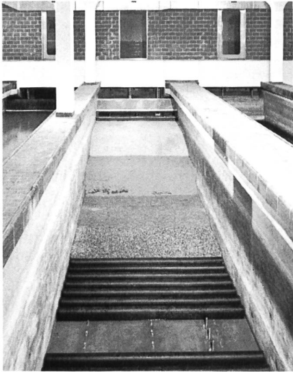
Bild 2. Sulzer-Drainagefilterboden in der Wasserversorgung Zürich.
