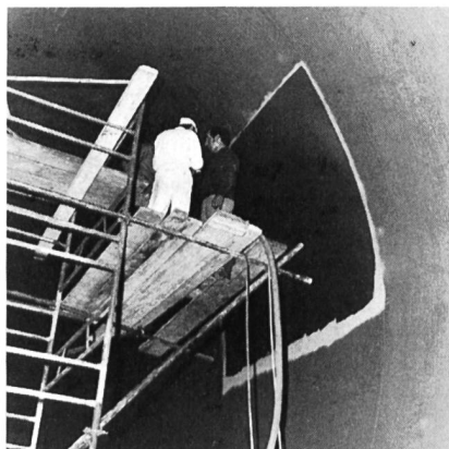
Bild 4. Ansetzen eines Kontrollfeldes in einer Druckleitung mit 7 m Durchmesser.
