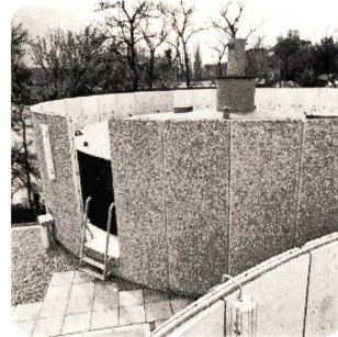
Faulanlage, Villette, Gent
