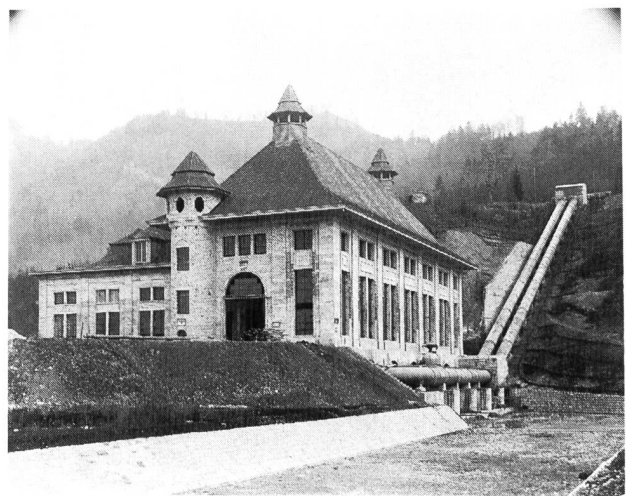
Figure 1. La centrale EEF de Broc avec la conduite forcée double de 1,8 m de diamètre intérieur, avant son remplacement en 1987 par une conduite unique de 3 m.
