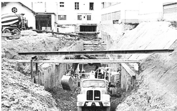
Bild 5. Aushubarbeiten für die neue Zentrale.
