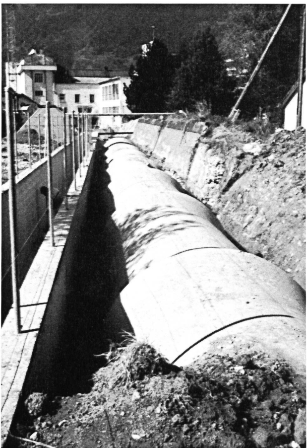
Bild 6. Der Bau der Druckleitung (rechts) und des Leerschusskanals.
