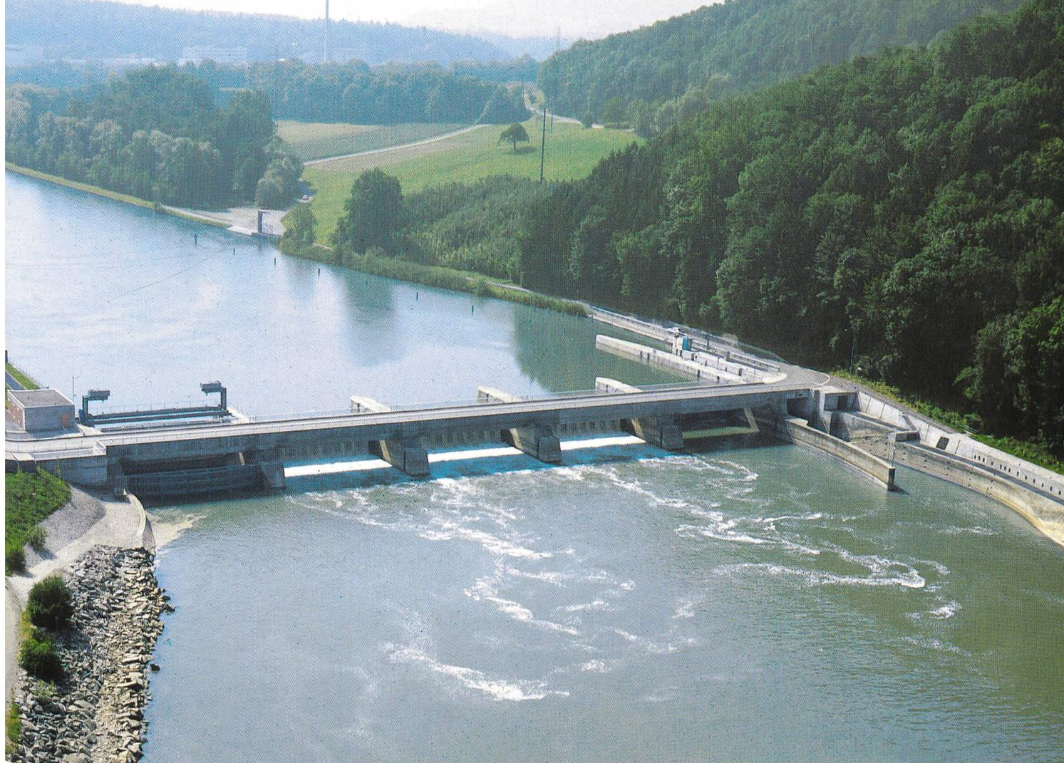
Das Stauwehr der Wasserkraftanlage Beznau aus den Jahren 1898 bis 1902 wurde durch ein neues Wehr ersetzt. Nach einer Bauzeit von 5 Jahren konnte das neue Wehr 1986 in Betrieb genommen werden. Auf den Seiten 33 bis 38 werden die Schäden und ihre Behebung beschrieben, welche nach den Hochwasserabflüssen im Jahre 1987 am Wehr aufgetreten sind.
