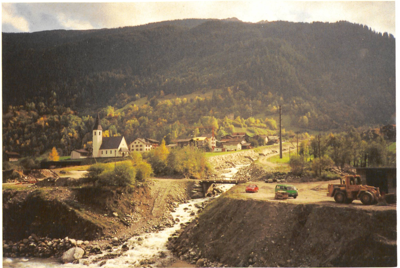
Bild 6. Zignau im Herbst 1988. Man erkennt das Gerinne, das die Rufe am Ort vorbeileiten konnte und den Schaden in Grenzen hielt. Bis wieder Gebüsch die Verbauungen verdeckt, werden allerdings noch einige Jahre vergehen (vgl. Bild 5).
