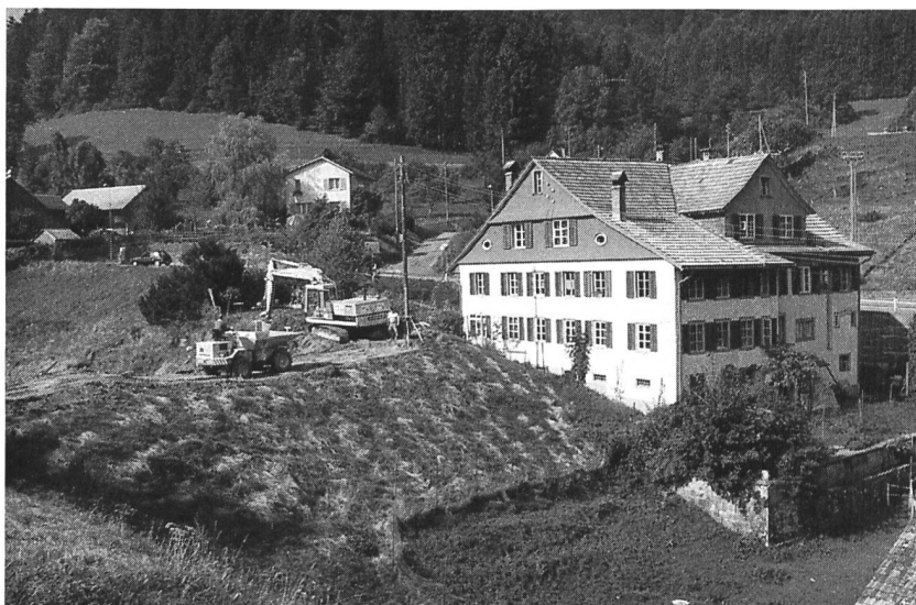
Bild 1. Damm Unterer Weiher mit ehemaliger Mühle Muetsbach – Ansicht von unten. Die Baumaschinen im Bilde sind mit dem Abtrag der Dammkrone beschäftigt. Zusammen mit der neuen Hochwasserentlastung und weiteren baulichen Massnahmen wird damit die Gewähr für die geforderte Sicherheit gegeben sein.
