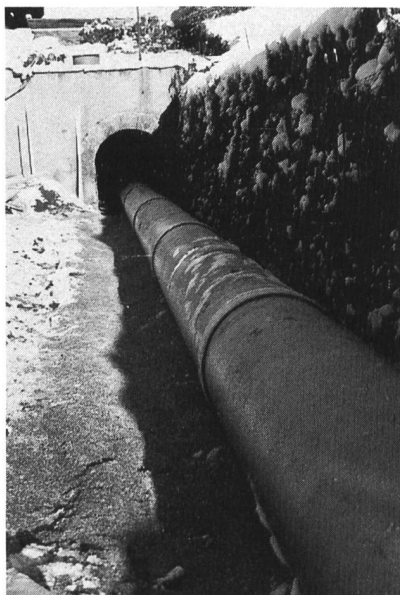
Bild 1, links. Die genietete Druckleitung mit einem Durchmesser von 1000 mm der Textilfirma Spälty & Cie. AG in Netstal stand 1901 bis 1988 in Betrieb. Die Leitung war bis kurz vor der Fabrik offen geführt. Die letzten 10 m vor der Turbine lag sie in einem Rohrstollen.
