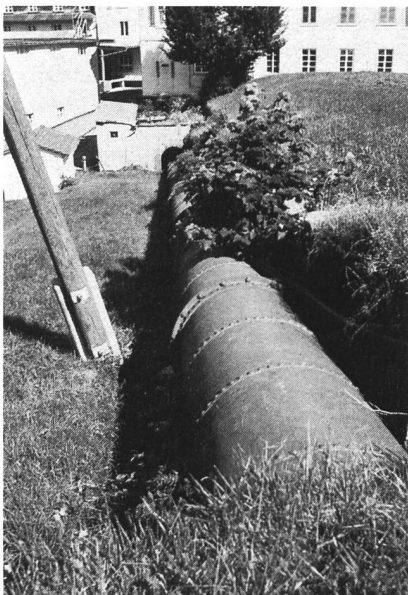
Bild 1, links. Die genietete Druckleitung mit einem Durchmesser von 1000 mm der Textilfirma Spälty & Cie. AG in Netstal stand 1901 bis 1988 in Betrieb. Die Leitung war bis kurz vor der Fabrik offen geführt. Die letzten 10 m vor der Turbine lag sie in einem Rohrstollen.
