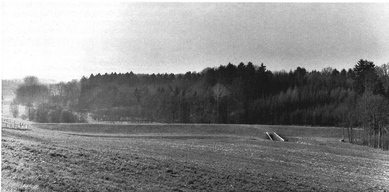
Bild 7. Hauptdamm luftseitig, in rechter Bildhälfte Auslaufbauwerk.
