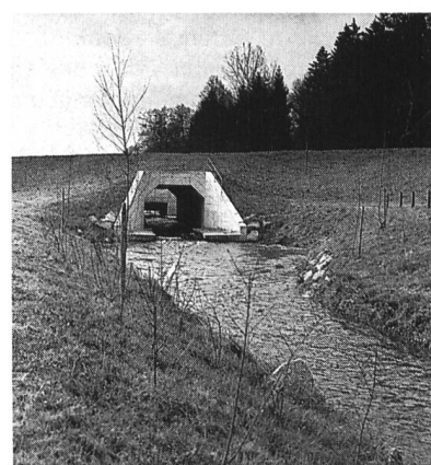
Bild 10. Auslaufbauwerk des Ableitkanals mit Tosbecken.
