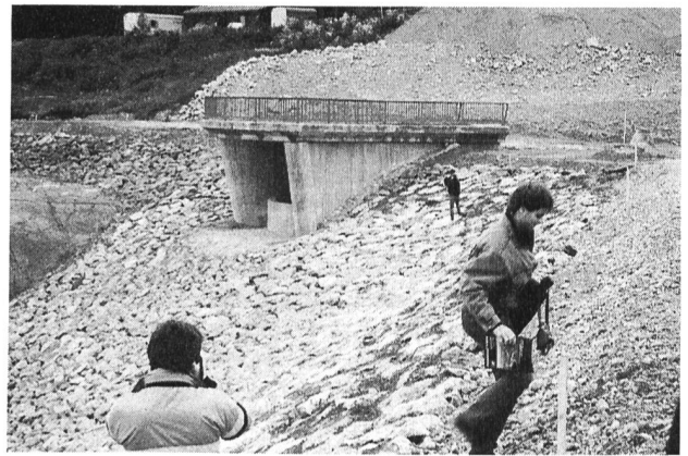
Bild 2. Rottachtalsperre: Einlauf zur Hochwasserentlastung.
