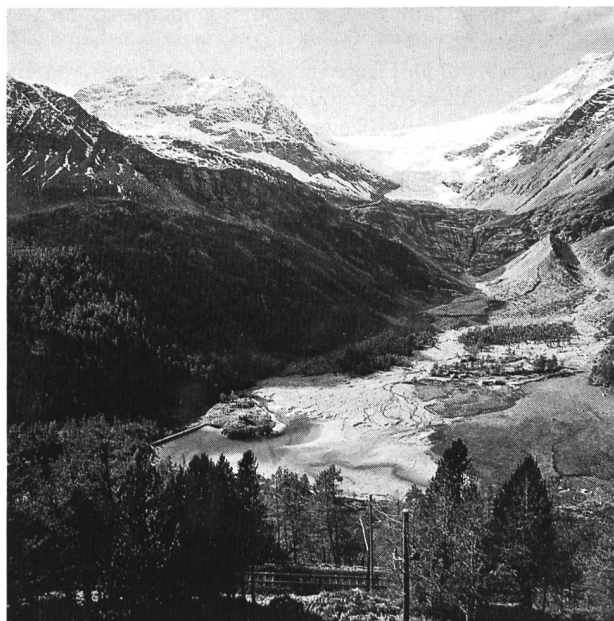
Bild 2. Das 1927 geschaffene Ausgleichsbecken Palü kann von der Station Alp Grüm der Berninabahn direkt eingesehen werden. Die Staukote dieses Beckens soll nach neueren Projektstudien nicht erhöht werden, sofern der Lago Bianco entsprechend höher gestaut werden kann. Es soll lediglich das ursprüngliche Ausgleichsvolumen des Palübeckens wiederhergestellt werden.
