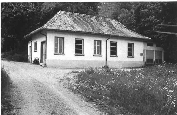
Bild 1. Das bestehende Kraftwerksgebäude wird durch den Umbau in seinem Äusseren nicht verändert.
