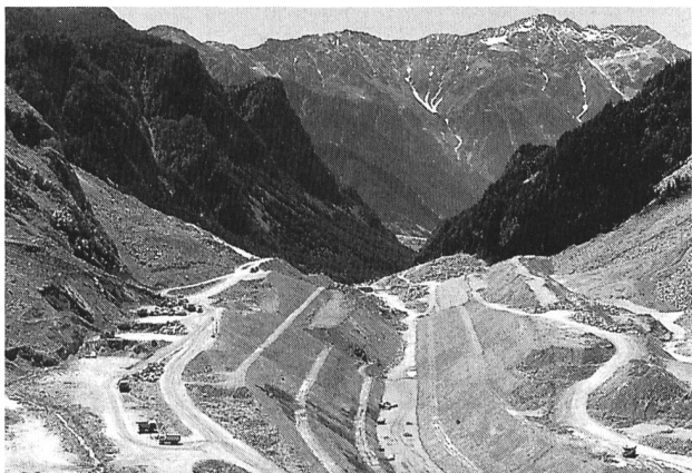
Bild 5. Überlaufkanal im flachen Teilstück. Blick talauswärts (Foto A. Huber).
