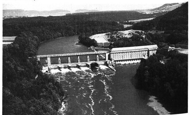
Bild 36. Luftaufnahme des von den renommierten Architekten Gebr. Pfister, Zürich, gestalteten, 1920 in Betrieb genommenen Rheinkraftwerkes Eglisau (33 MW), 24 km nördlich von Zürich (Foto NOK, Baden).
