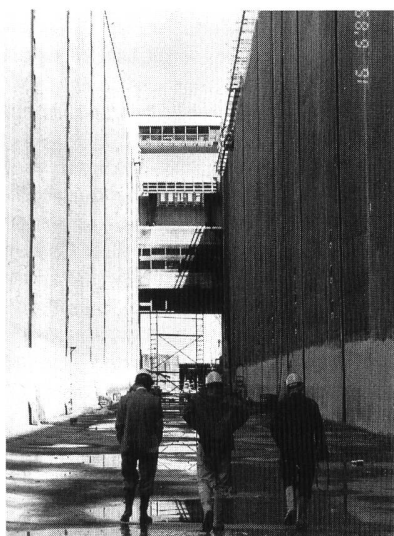
Bild 1, links. Blick in die 200 m lange und 30 m hohe Schleusenkammer vor den Sanierungsarbeiten: Abbruch des nicht frostbeständigen Betons und Ersatz desselben durch Spritzbeton.
