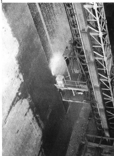
Bild 1, links. Blick in die 200 m lange und 30 m hohe Schleusenkammer vor den Sanierungsarbeiten: Abbruch des nicht frostbeständigen Betons und Ersatz desselben durch Spritzbeton.
