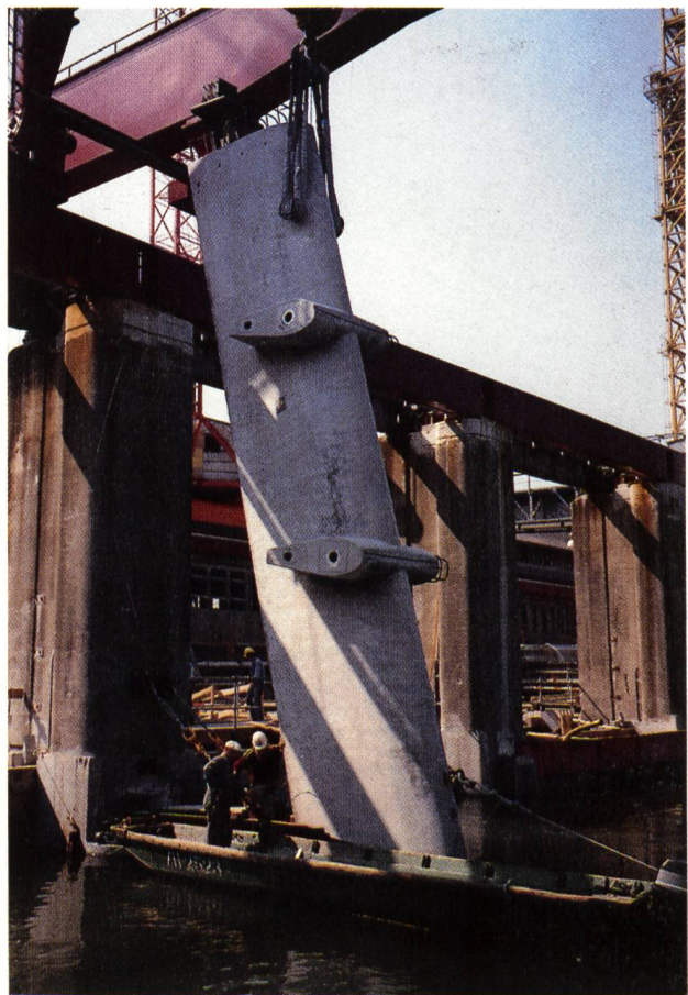
Bild 11. Montage einer Schrägstütze des Einlaufrechens.
