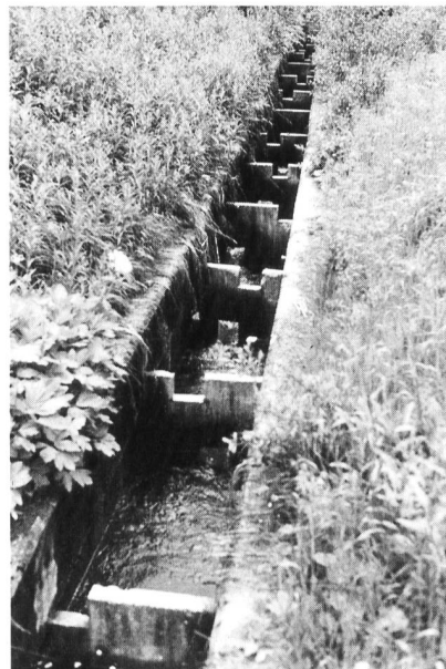
Bild 13. Beckenpass von Charnadura am Inn bei Celerina.
