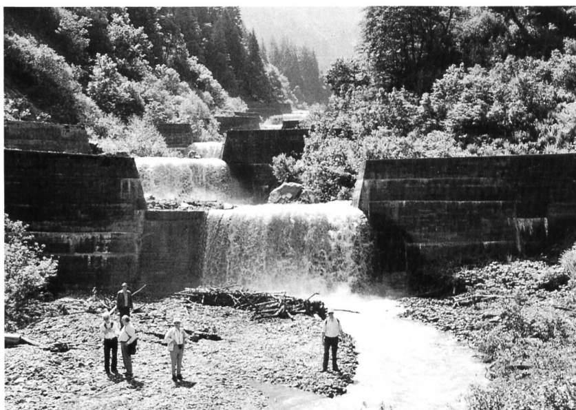
Bild 1, links. Der untere Teil der Sperrentreppe im Durnagelbach hält die Seitenhänge zurzeit gerade so stabil, dass sich die Vegetationsdecke wieder zögernd aufbauen kann.
