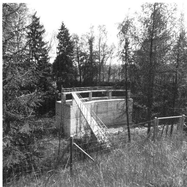
Bild 9. Hochwasserentlastungsbauwerk mit Zugangssteg (Blick vom Stassendamm).
