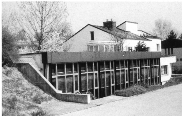
Bild 1. Dieser längliche eingeschossige Bürotrakt (10 x 20 m) in Jona (SG) ist an ein bestehendes Wohnhaus angebaut worden. Das ganze Gebäude ist erdbühnt und erdbedeckt, so dass das Gelände über dem Bürotrakt wieder als Grünfläche dient.
