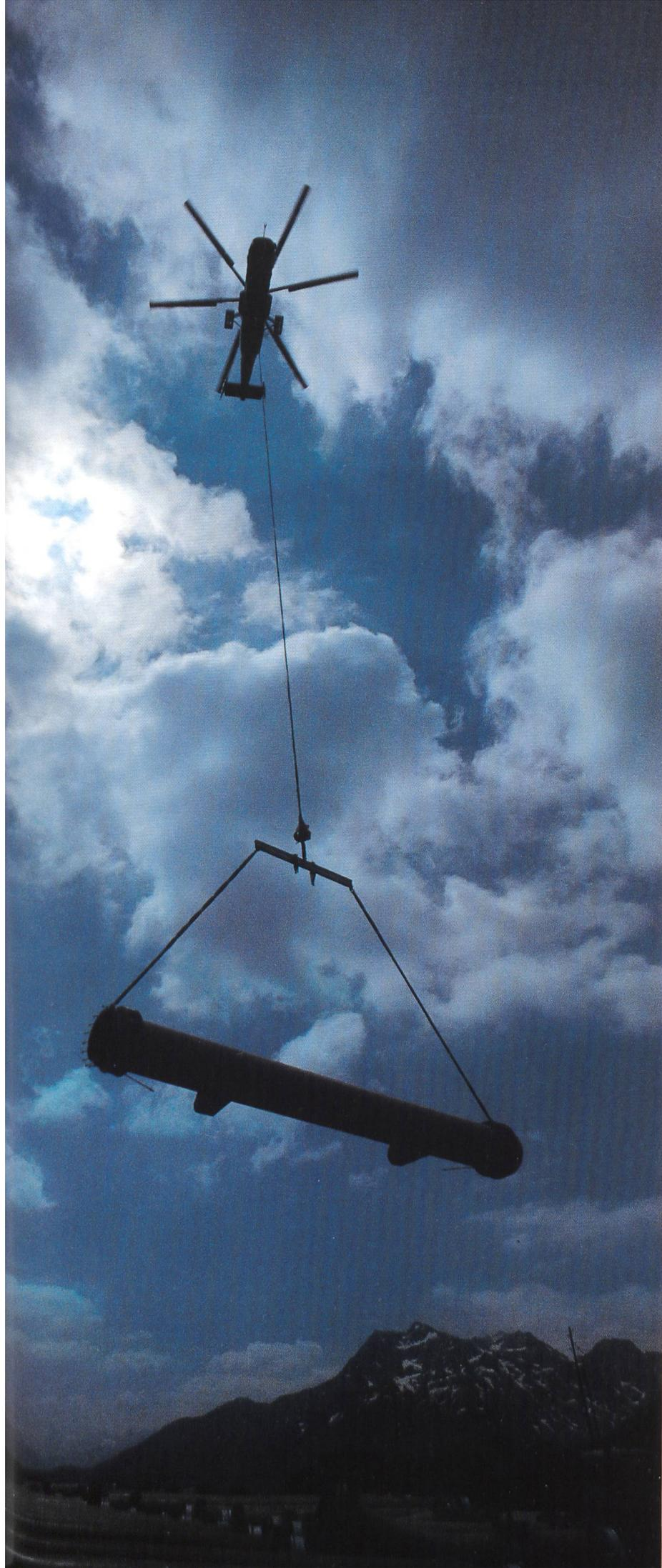
Einfliegen von Druckrohrschüssen mit dem Helikopter. Siehe auch «Sella – ein Kleinkraftwerk am Gotthard», Seite 82.
