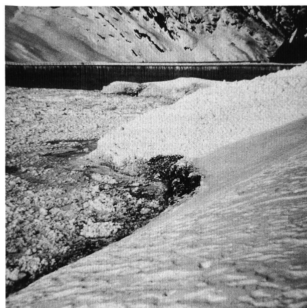
Bild 7. Blick auf das rechte Widerlager der Räterichsbodenmauer und den Kegel der einmündenden Gärstenbachlawine. Die Lawine durchbrach die Eisdecke und führte zur Wellenbildung, was an der Auflauhöhe an den Ufern sichtbar wurde.
