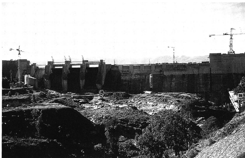
Figure 1. Vue aval en cours de surélévation.
