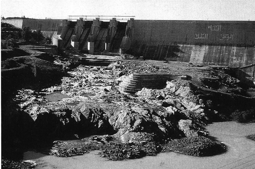
Figure 2. Vue aval après surélévation.
