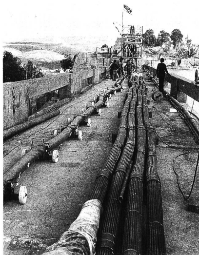
Figure 7. Tirants d'ancrage. Quelques tirants principaux, non encore pourvus de leur gaine extérieure. A l'arrière-plan la roue d'enfilage.
