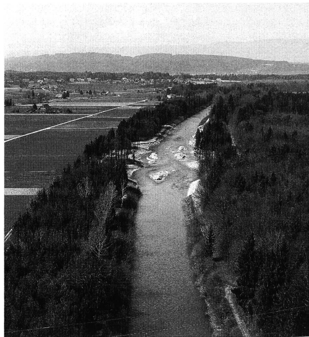
Bild 2. Analoges Bild wie 1, Zustand nach der Aufweitung des Profils (Documenta Natura).
