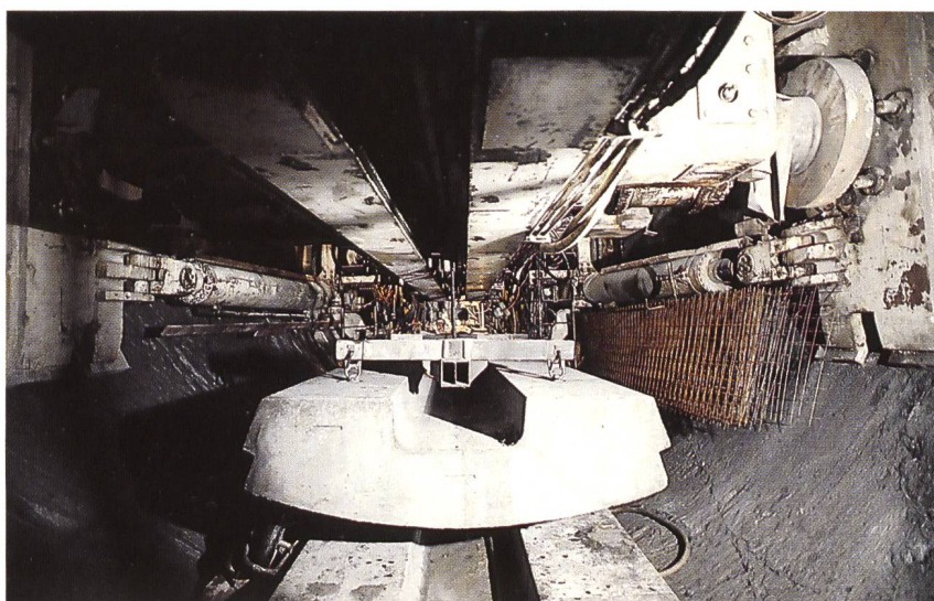
Bild 4.3. Sohlübende als temporäre Schienenschwellen werden in Baulos 3 in die Stollenverkleidung integriert.
