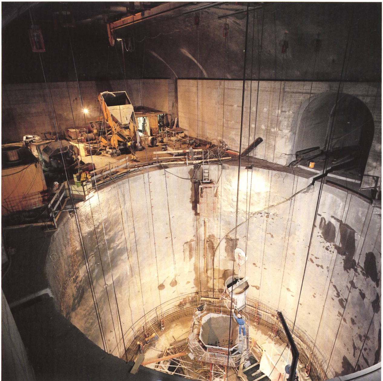
Bild 5.3. Die Betonauskleidung des Vertikalschachtes erfolgte mittels Gleitschalung vom Schachtfuss nach oben. Zur Abdichtung des Schachtes ist eine Dichtungsfolie auf den mit Gunit geschützten Fels aufgebracht worden (Foto Wolf, Schruns).
