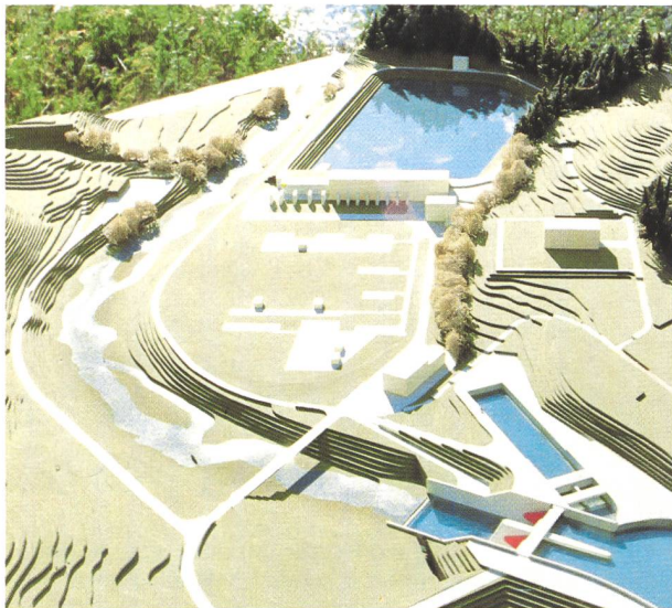
Bild 1.2. Die Anordnung bei Pradella: Inn-Wasserfassung, Betriebsgebäude, Freiluftschaltanlage, Zentrale und Ausgleichsbecken. Dargestellt als Modell.
