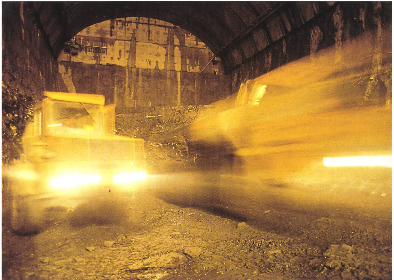
Bild 6.8. Ausbrucharbeiten in der Kaverne. In der Zeit vom Februar 1991 bis September 1991 wurde die Kavernenzentrale mit einem Volumen von etwa 40000 m 3 (fest) ausgebrochen. Das Bild gibt einen Eindruck vom regen Baustellenverkehr, der in dieser Zeit herrschte. Im Hintergrund ist das bereits fertiggestellte Ortsbetongewölbe zu erkennen.
