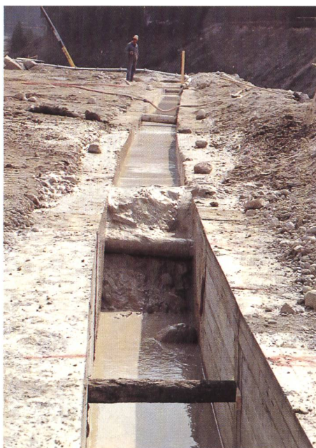
Einphasendichtungswand in Ausführung.
