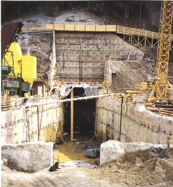
Bild 3.13. Vom tiefsten Punkt des Einlaufbauwerkes wird im fallenden Vortrieb der Druckstollen ausgebrochen und betoniert.
