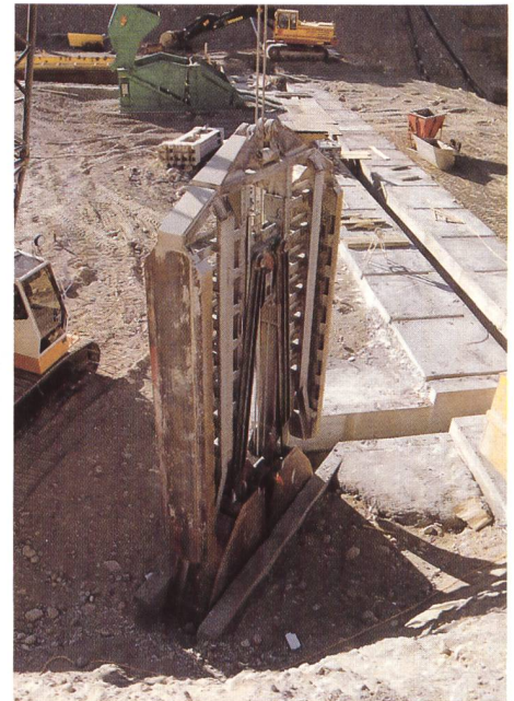
Einphasendichtungswand in Ausführung.
