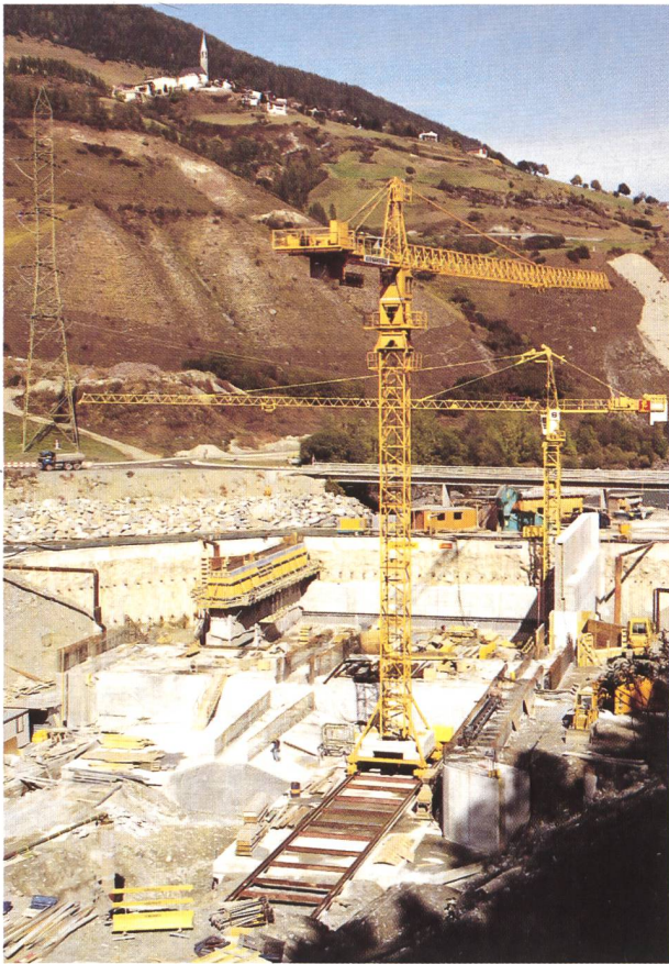
Bild 3.7. Wehranlage im Bau (Stand November 1991), Blick flussabwärts. Im Hintergrund Zufahrtsbrücke zur Zentrale Pradella und Dorf Sent.
