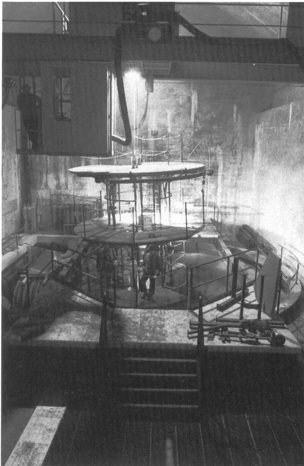
Bild 5. Dreistöckige Arbeitsbühne, bereit zum Absenken in den 130 m tiefen Schacht Peccia.
